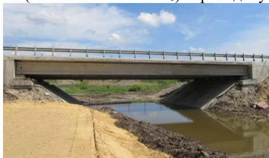
Рис. 1. Железобетонный мост с автодорожной балкой
